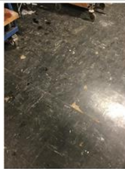
Déclaré - D10 : SOUS SOL - Dalle de sol - AC1- (Présence d'amiante)
