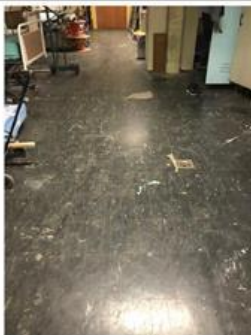
Déclaré - D12 : SOUS SOL - Dalle de sol - EP- (Présence d'amiante)
