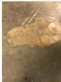
Déclaré - D11 : SOUS SOL - Dalle de sol - AC2- (Présence d'amiante)
